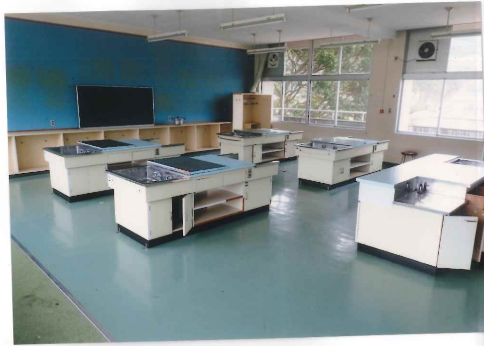
着工前家庭科室
