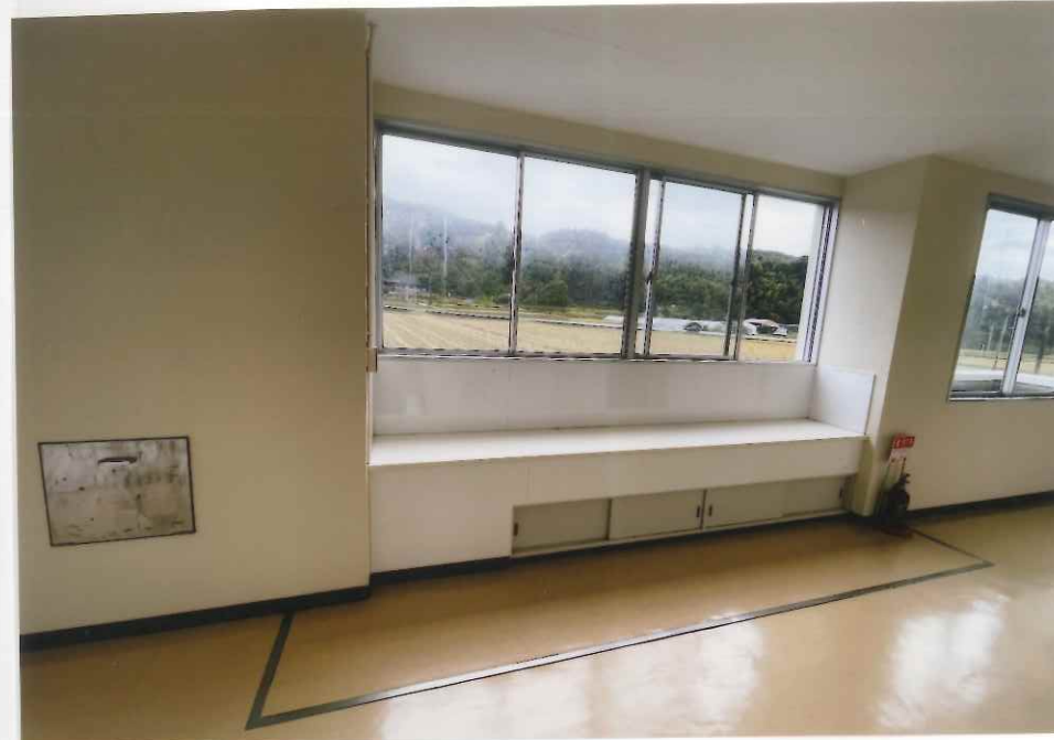
改修完了 階段と廊下
